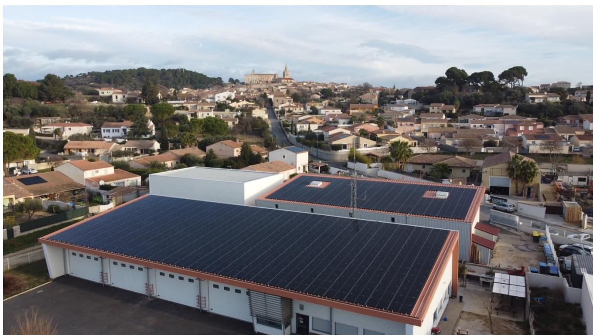
La mise en place de l'autoconsommation collective a permis de faire fonctionner 41 % des besoins énergétiques des bâtiments concernés avec de l'électricité solaire, soit environ 85 360 kWh par an. Ce système permet de réaliser une économie moyenne de 20 % sur les factures d'électricité de ces bâtiments.
